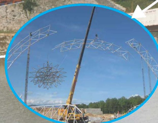
Thi công lắp dựng
